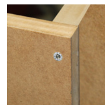
Evita que se agriete la madera
