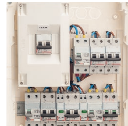
1 Posibilidad de incorporar el interruptor de control de potencia. Possibility of adapting a main power breaker switch.
