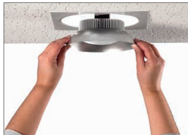
5: Insertar en la carcasa del downlight.
