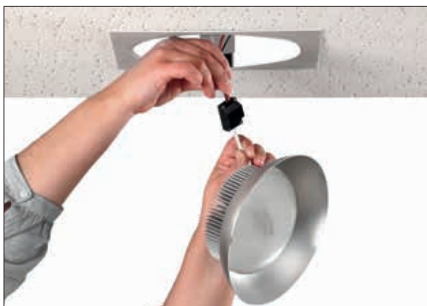
4: Conectar directo a red mediante caja de conexiones.
