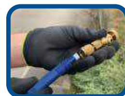
Colocación de nueva junta
