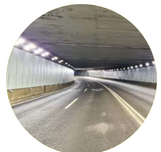
Túnel Bonanova Barcelona
