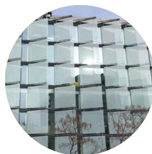
Edificio de Oficinas Suero de Quiñones, 42
